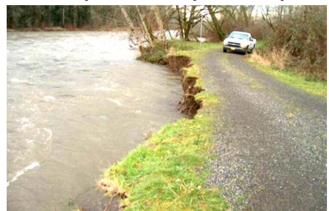
Рис. 9. Наслідки розмиву берегу річки поблизу автотраси [10]
