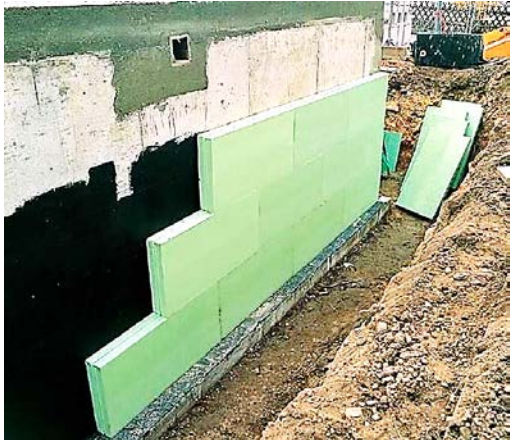
Рис. 3. Утепление с помощью плит пенопласта
