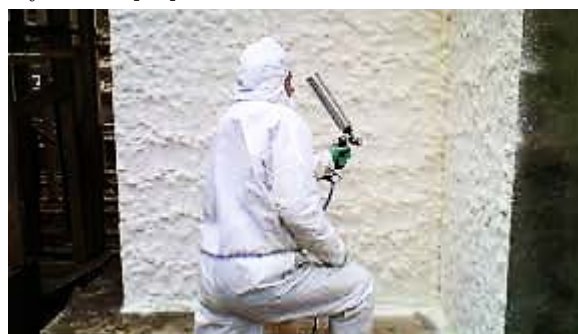
Рис. 8. Распыление на поверхность пенополиуретана
