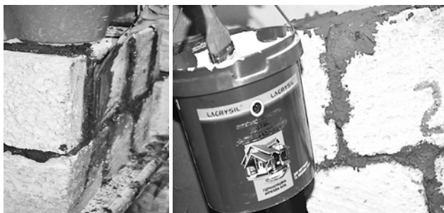
Рис. 2. Рабочий фрагмент нанесения составов гидроизоляции
